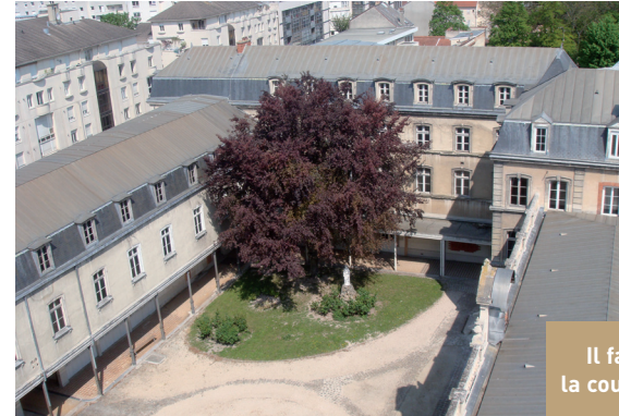
vue partielle sur cour d'honneur
