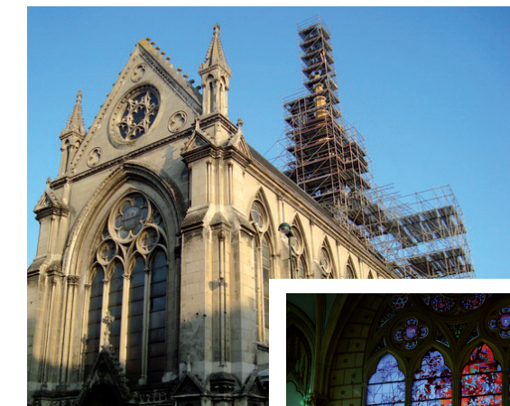
la chapelle Saint-Joseph pendant les travaux
