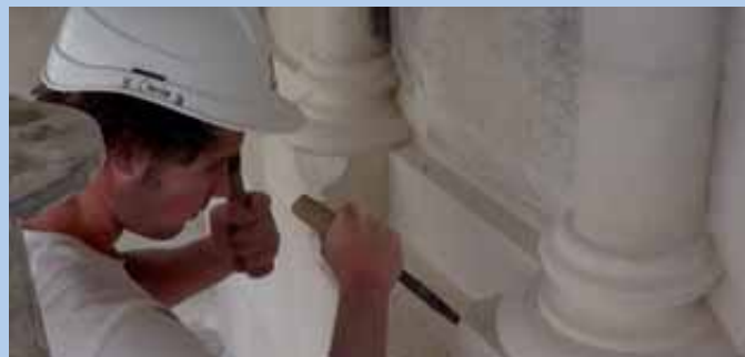
Pour l'entreprise de taille de pierre et de sculpture Léon-Noël , la restauration de la façade de la rue de Venise représente près de 8 000 heures de travail, soit 8 salariés à temps-plein pendant 6 mois !
