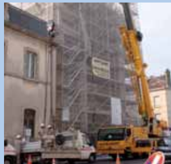
D'une hauteur de 3,50 mètres, le fleuron a été restauré en atelier avant d'être reposé au sommet de la façade fin juillet
